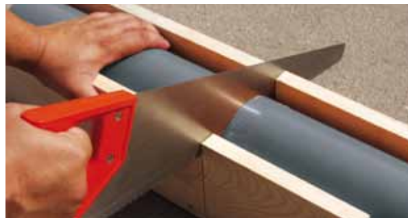
Obrázek 2 Úkos dodatečně zkrácené trubky
